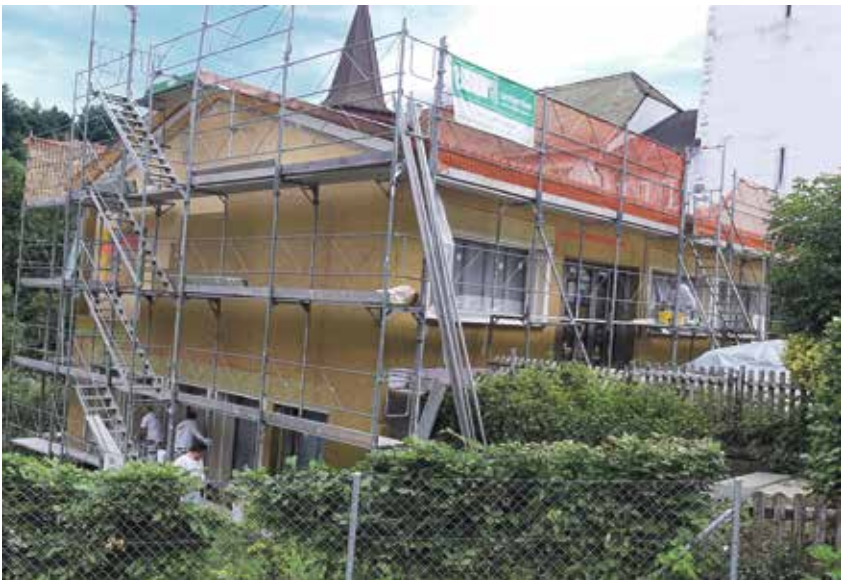
Fassadenarbeiten im Gang
