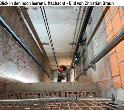
Blick in den noch leeren Liftschacht - Bild von Christian Braun
